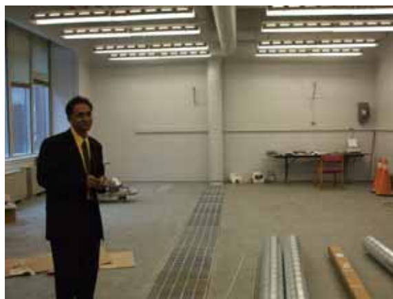
写真 2 新規射出成形機導入工事場所 (中で自動車部品の試験が行われていた)
