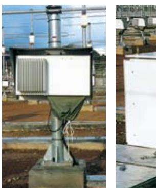
▲ 送受信モジュール(左), 電源収容架(中), 分配器収容架(右)
