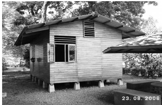
f) 耐震住宅の完成
