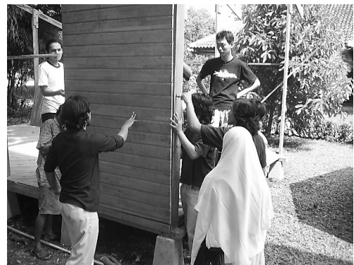
d) プレファブ生産された耐力壁ユニットの組み込み
