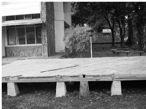
a) コンクリート製独立基礎と床構面の施工
