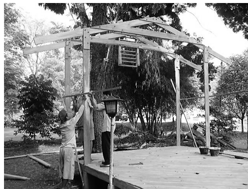
b) 骨組み架構の製造と建ち上げ
