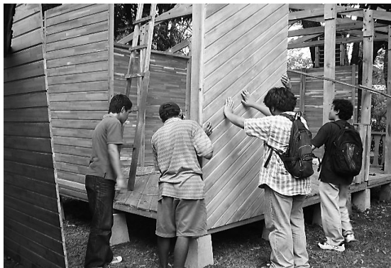
e) プレファブ耐力壁ユニットの組み込みとバルコニーの設置
