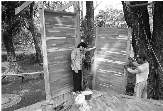
d) プレファブ生産された耐力壁ユニットの組み込み
