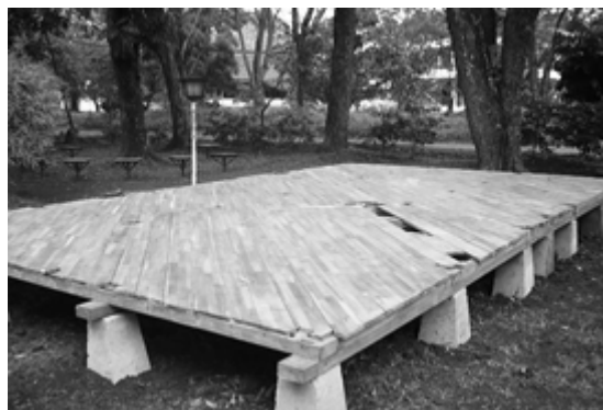
a) コンクリート製独立基礎と床構面の施工
