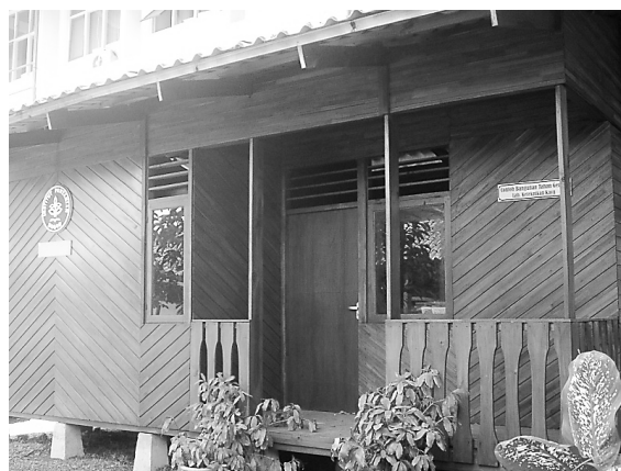
図8：プレファブシステムで造られた耐震モデル住宅
