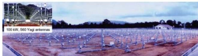
赤道大気レーダー（インドネシア・スマトラ島の赤道直下に設置された大気観測用大型レーダー） Equatorial Atmosphere Radar; EAR located in West Sumatra Republic of Indonesia.
