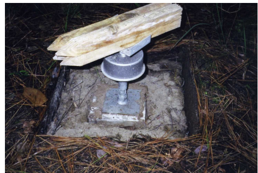
図2：同じく17年度に設置し、18年度に移設した防蟻束試験体束石における蟻道の拡大（2年半経過）。昨年の観察結果と比較して、蟻道の拡大が認められる。
