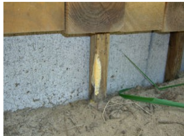
写真2 腐朽菌の様子
