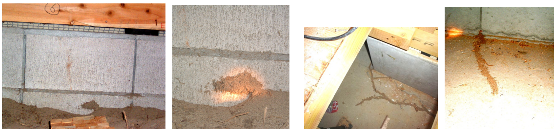
実験棟②で確認された突起蟻道痕(右: 詳細) 木造建物の床下で見られた気流忌避蟻道
