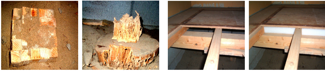
①、床下の餌木の食害状態。(完食状態) 【床組木部の含水率】
