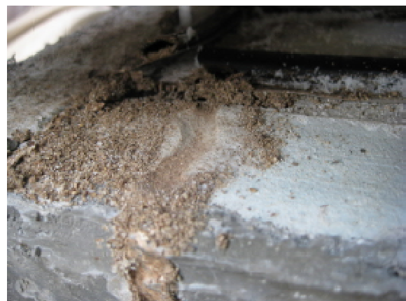
図 2 食害の認められた断熱材表面
