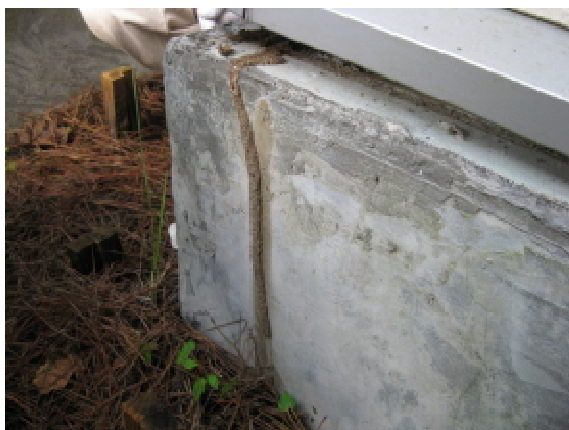
図 1 外壁面の蟻道
